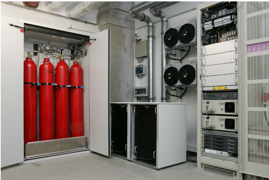
Brennstoffzellen-Anlage im Rheinenergiestadion Köln
